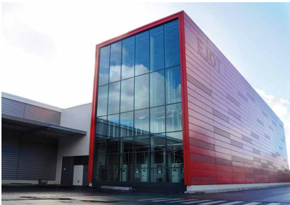
Das Hochregallager in der Astenbergstraße
