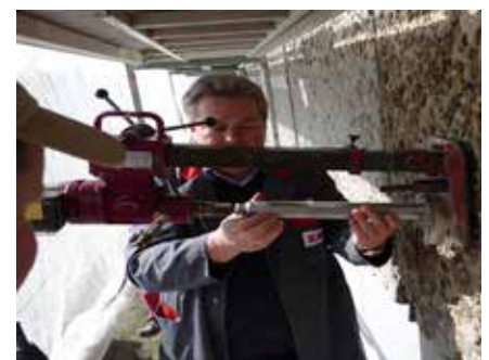
Auszugsversuch auf der Baustelle
