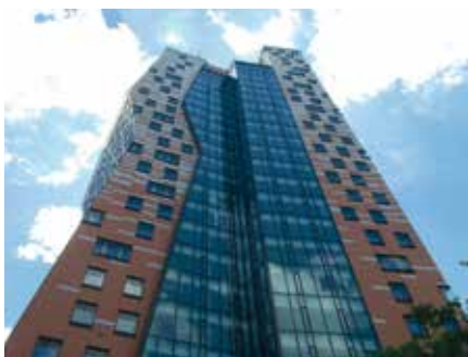
AZ Tower Brunn, Tschechien. Das höchste Gebäude Tschechiens mit WDVS Produkten von EJOT.
